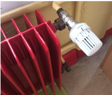
Écoles : Pose de robinets thermostatiques par SANIPROCLEAN pour 12 753,41 € TTC
