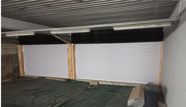
Pose de portes de garage pas de tir par MONSIEUR STORE KEN STUDLÉ pour 9 400,90 € TTC
